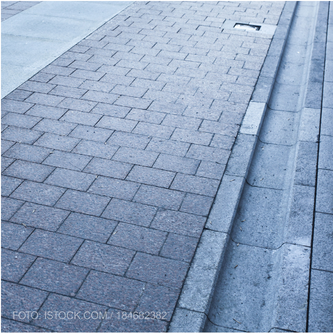
OTEVŘENÝ PODÉLNÝ ODVODŇOVACÍ ŽLAB
