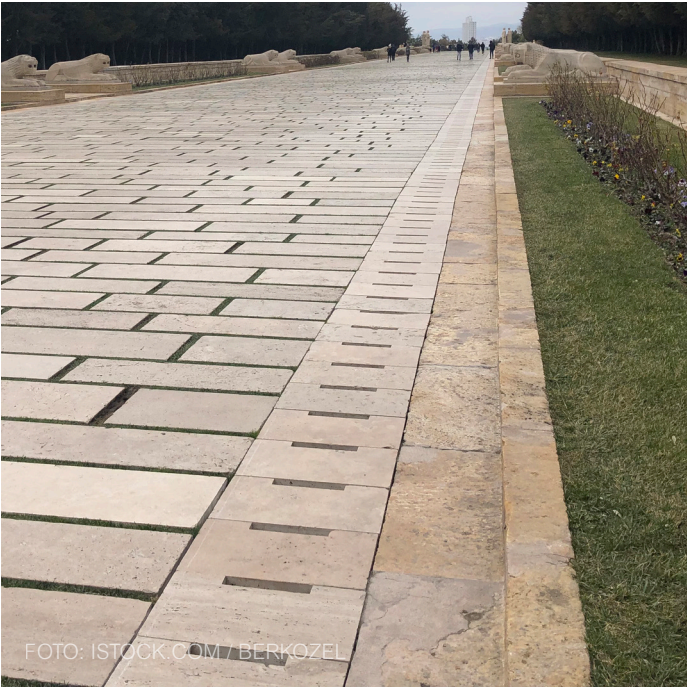
UZAVŘENÝ PODÉLNÝ ODVODŇOVACÍ ŽLAB
