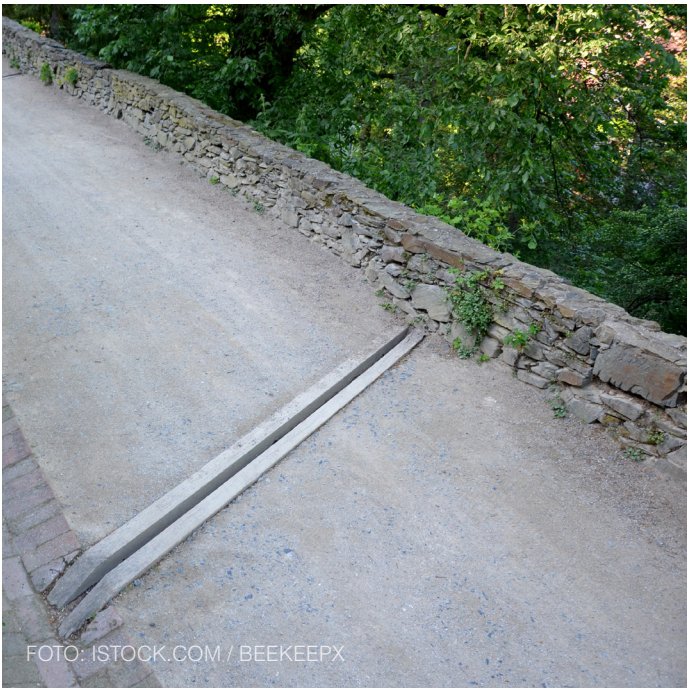
OTEVŘENÝ PŘÍČNÝ ODVODŇOVACÍ ŽLAB
