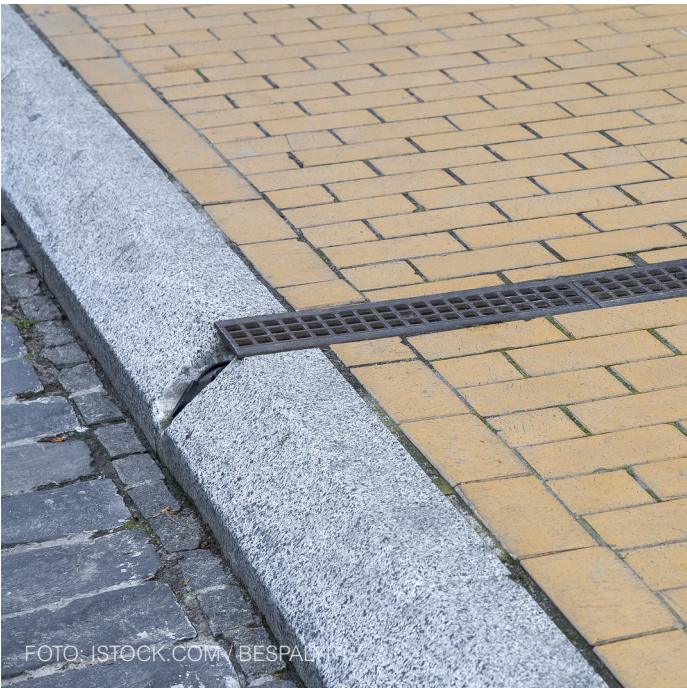
UZAVŘENÝ PŘÍČNÝ ODVODŇOVACÍ ŽLAB
