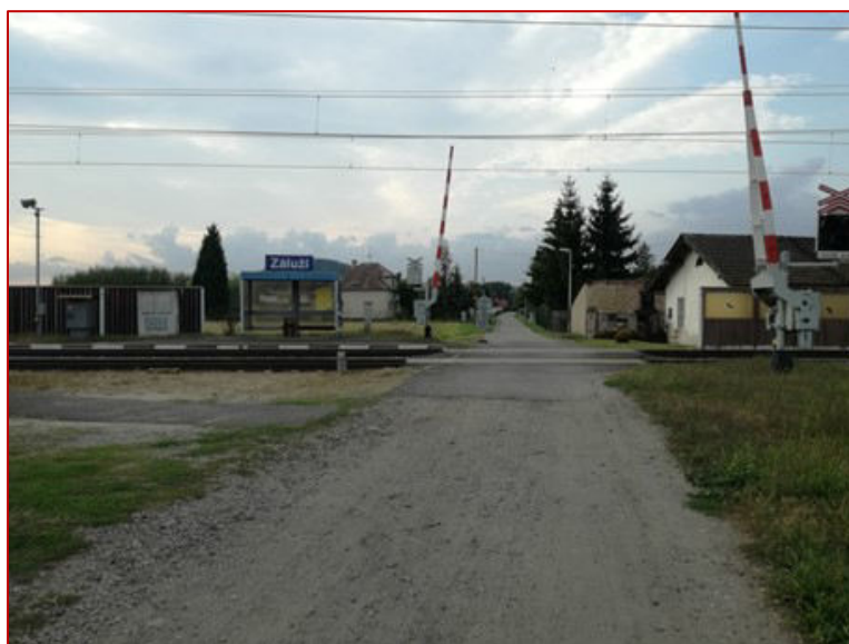
Obrázek 2: Křížení dráhy a cyklostezky UČS 5.2.1. – pohled z nově budovaného úseku
