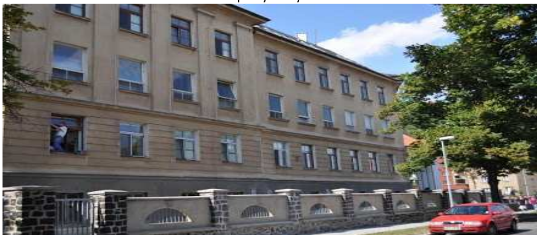
I. etapa výměny oken
