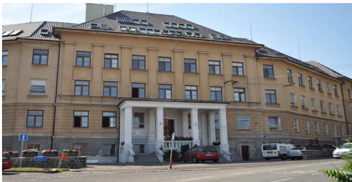
Sociální zařízení před opravou
