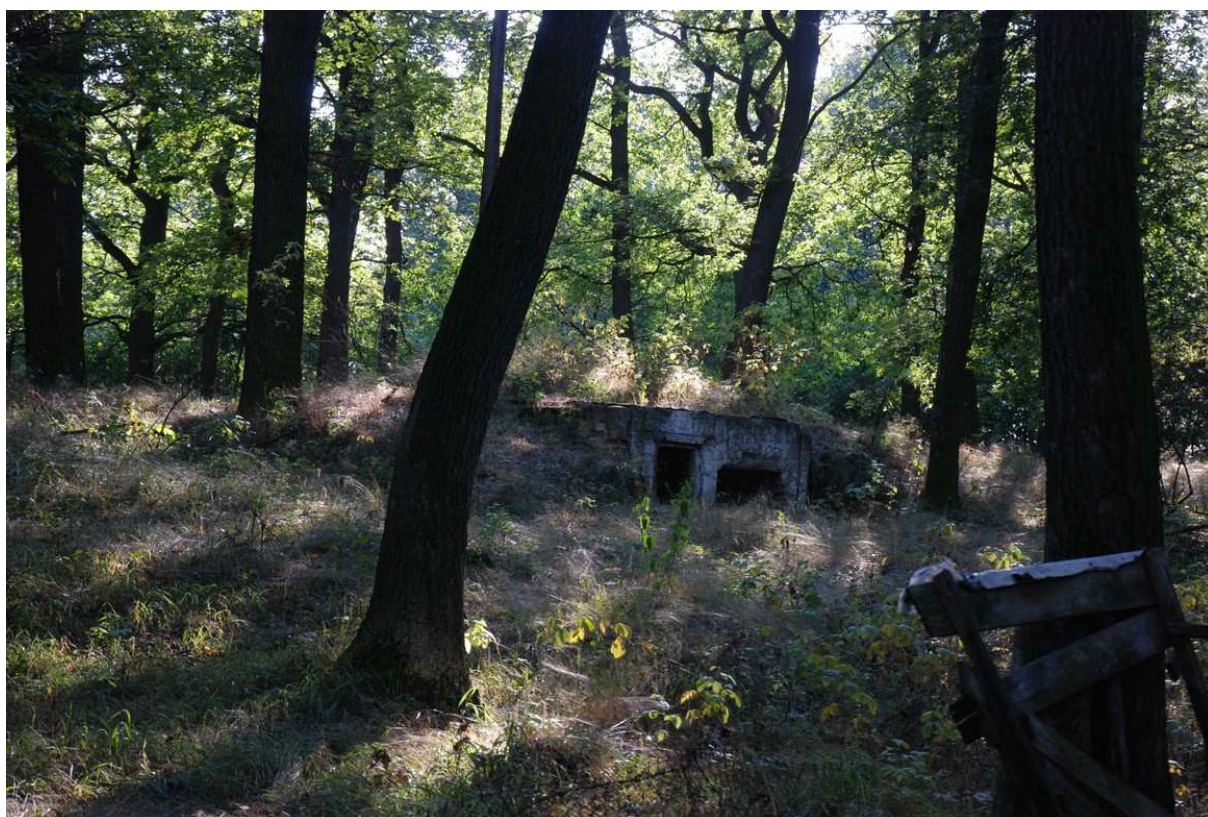
Zchátralé objekty, které na lokalitě zanechala armáda
