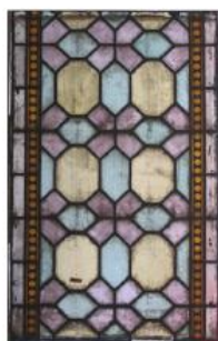
okenní vitráže pod pořadovým č. 20 (předsíň severního ochozu XLV/15)
